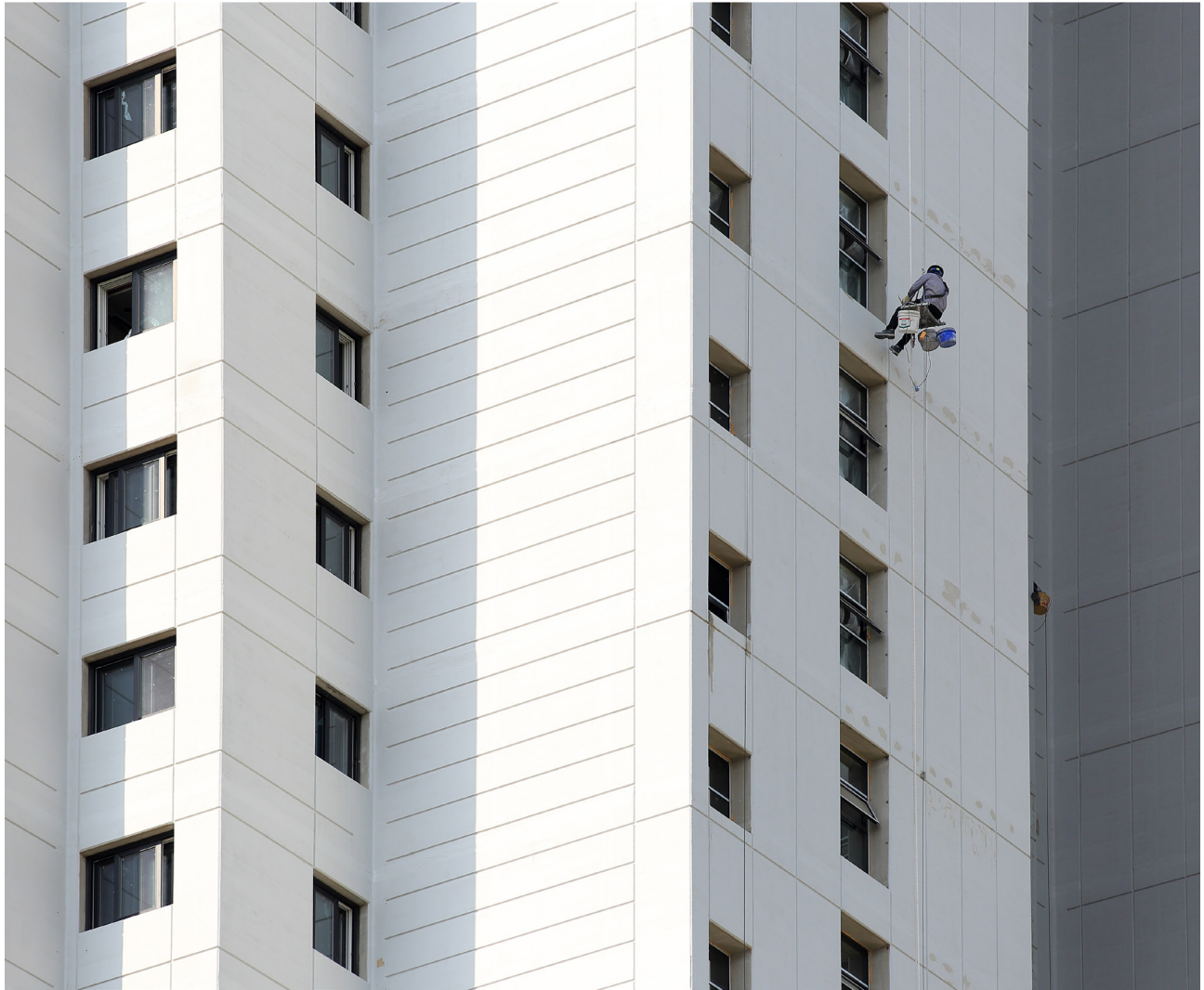
[달비계 작업을 통한 환기캡 설치]
