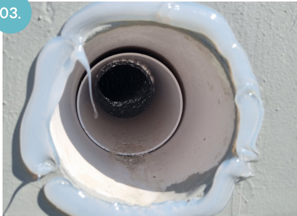
환기캡 시공 전 실리콘 도포
