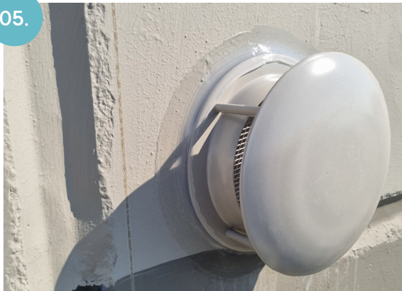
환기캡 실리콘 2차 시공 후 최종 마감 상태
